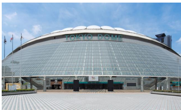
東京ドーム外観
